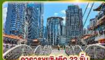
อาคารชวยซิงตึก 22 ชั้น
